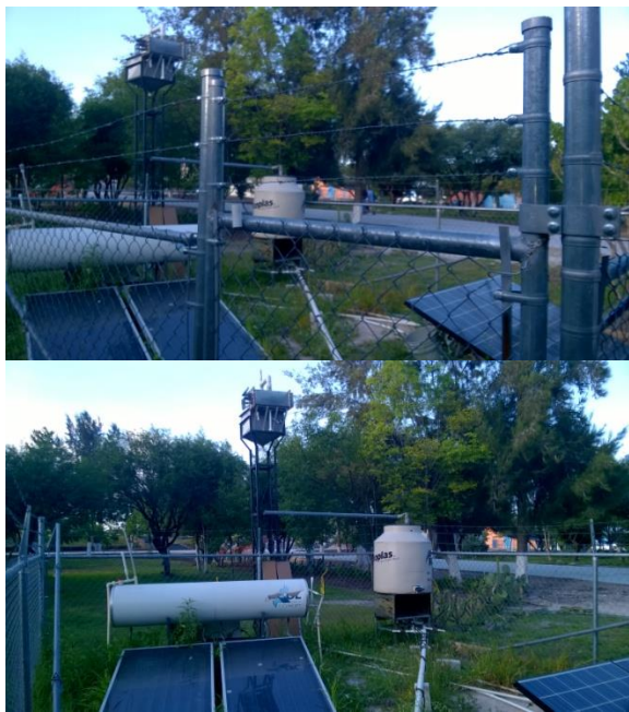
Figura 4 Imágenes de la construcción del sistema solar para destilación de agua.
