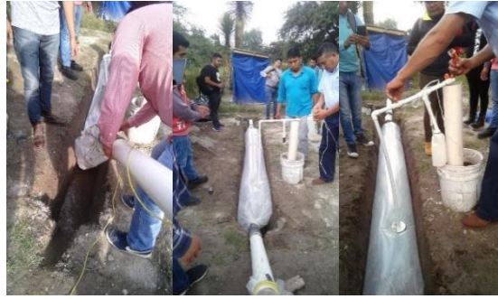
Figura 3 Instalación de biodigestor en la zanja
