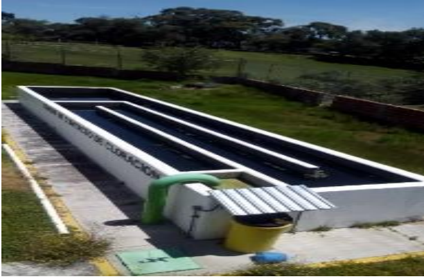
Figura 9 Tanque de contacto de cloración Fuente: Elaboración Propia
