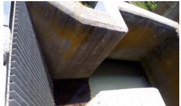
Figura 6 Entrada de sedimentado Fuente: Elaboración Propia
