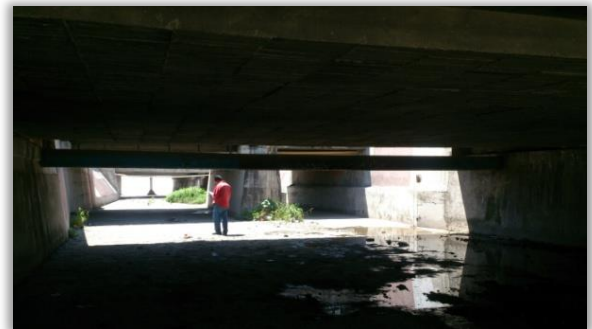
Figura 2: Puente 1 sobre la lateral del Bulevar Felipe Ángeles
