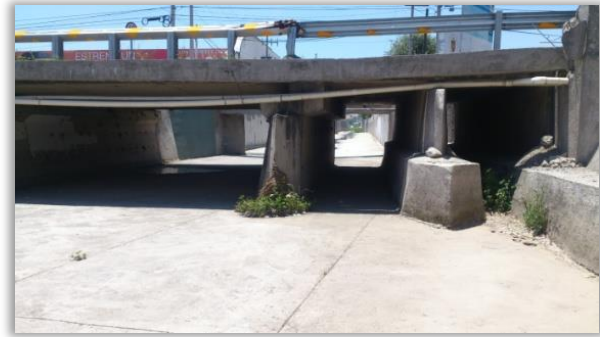
Figura 4 Pilas de apoyo del puente 3 en dirección México-Pachuca
