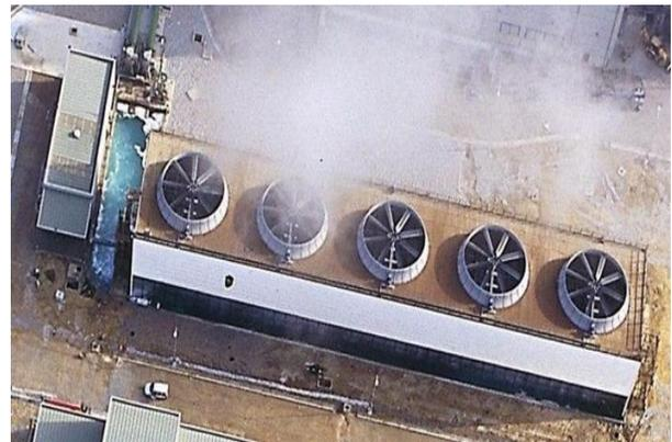
**Figura 6** Torres de enfriamiento sistema convencional
